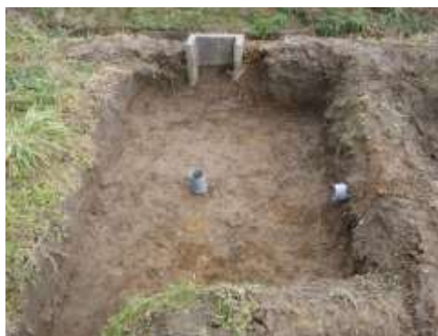
▲排水パイプと水田と連結する魚道パイプを整備
